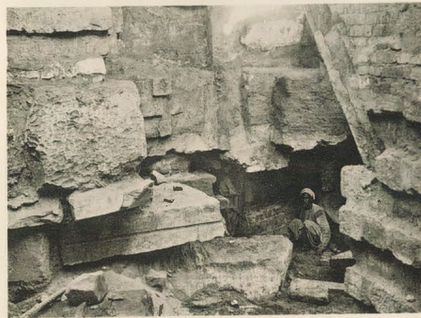
III e Pylône (aile sud). Découverte d'un mur bahut du monument de Senouosret I er . Au premier plan deux dalles de plafond du même monument.
